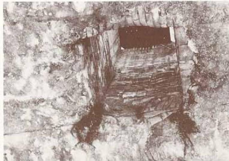
Le caratteristiche di questo passaggio sono costanti in tutti gli ambienti non trasformati. Una breccia esistente tra il primo ed il secondo ambiente, mostra la struttura della muratura in sezione.
