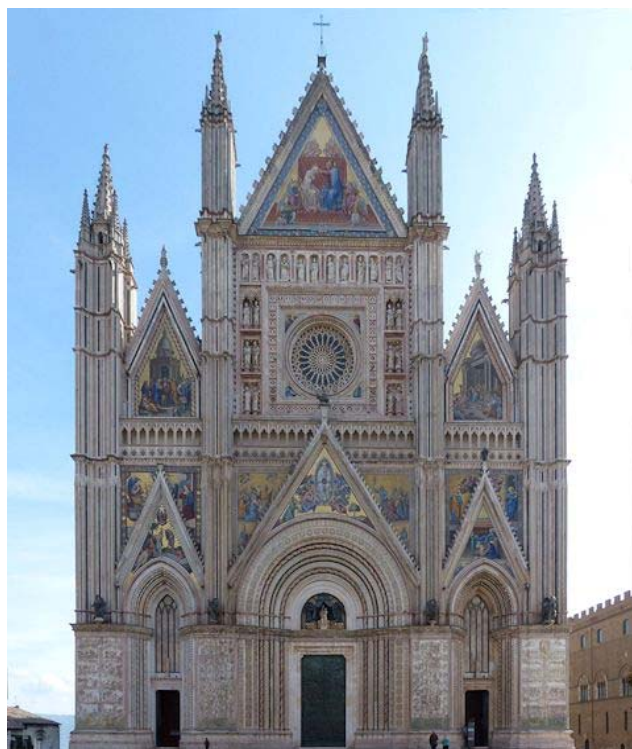
La facciata oggi
