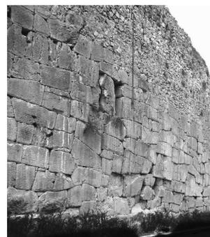
Oggi, con il solito anticipo, viene preannunciato il crollo della cortina muraria a chi usura ovest dell'ex Piazza Marconi, ex Ufficio Postale, e intorno, data la situazione statica, l'abbandono e l'ultimo sovraccarico aggiunto in maniera scellerata<sup>7</sup>.
