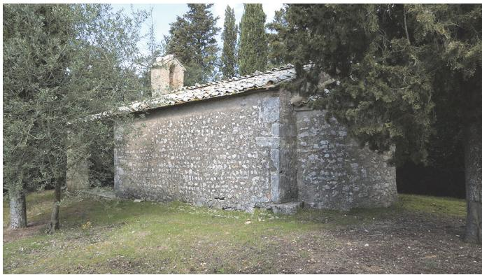
Sul lato absidale, i due cantonali si fermano pari sotto la gronda indicando il limite d'altezza del vano originario.
